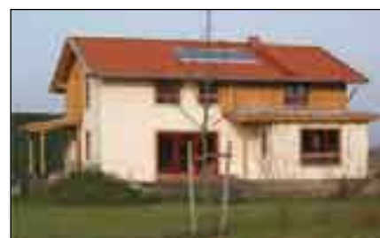
Abb.5 Fertig mit Kalk verputztes Strohballen-Haus (BV Bösel)
