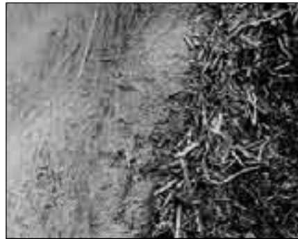
Abb.3 Anschnitt einer lehmverputzten Strohballenwand Lehmkuppel, Club 99, Ökodorf Sieben Linden
