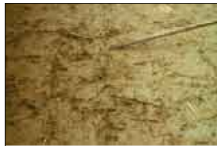
Abb.4 Fetter, sehr strohhaltiger Lehmputz auf Strohballen, Oberfläche gezogen, Club 99, Ökodorf Sieben Linden
