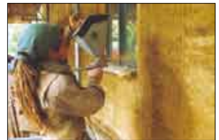
Abb.7 Vorspritzen mit Lehmschlämme
