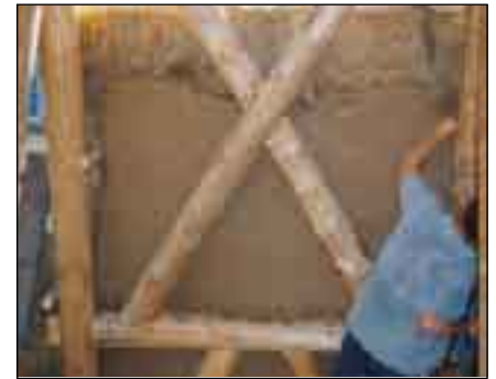
Abb.6 Beim Putzauftrag (ohne Maschine), BV Club 99, Sieben Linden
