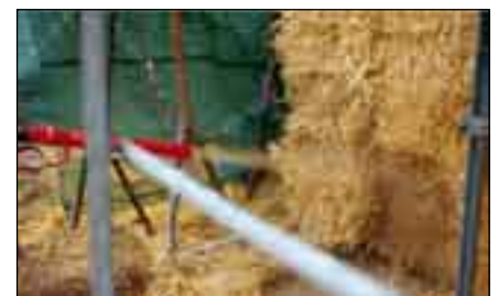
Abb.8 Putzauftrag mit Schleudertechnik (BV Bösel 2)
