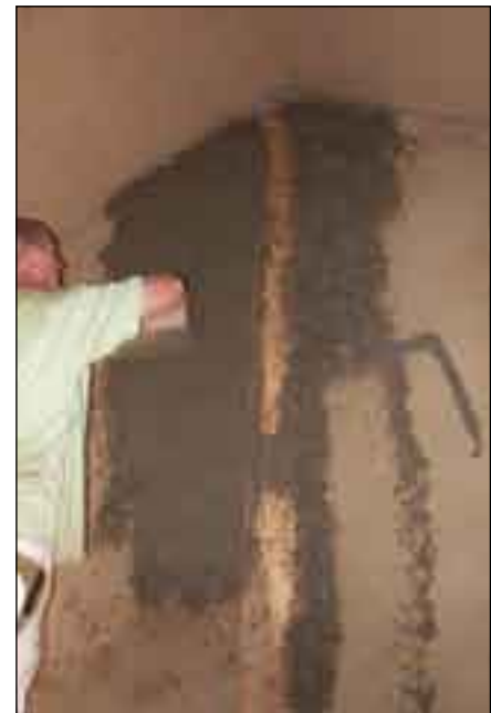
Abb.10 Aufbringen des Strohlehmputzes
