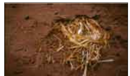
Abb.9 Mit dem Schleuderverfahren aufgebracht, schlecht haftender Lehmputz
