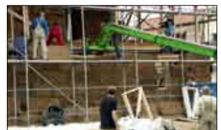
Abb.4 Einsatz eines Frontladers
