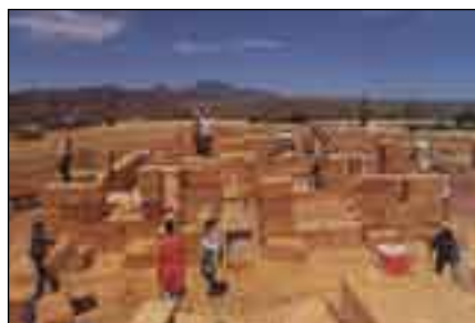
Abb.7 Strohballenbaustelle in den USA
