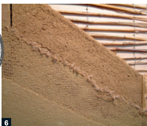
3 Konstrukce stěny s izolací ze štěpek obalených v jíl
