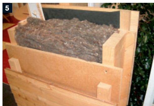
3 Konstrukce stěny s izolací ze štěpek obalených v jíl
