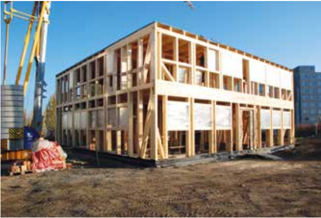
Das Holzskelett wurde auf der Baustelle erstellt
